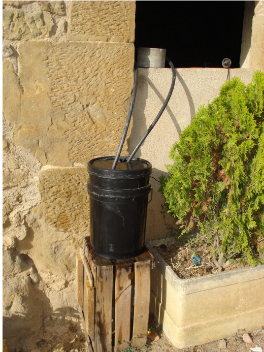
Sistema calefacció, un bidó negre exposat a la radiació del Sol. L'aigua calenta és bombada cap al serpentí que hi ha a l'interior del digestor.
