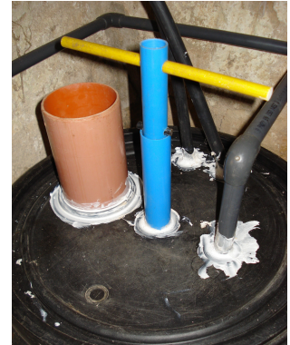
Aïllament components de la tapa
