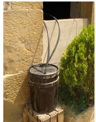
Sistema de calefacció
