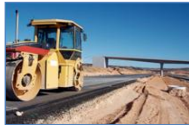
39. Elaboració d'una carretera.
