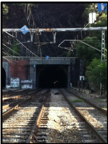
Fotografia del túnel de la via de tren Portbou Cervera
