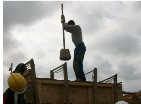
Imatge 33 Execució del mur tapià de l'escola. 43
