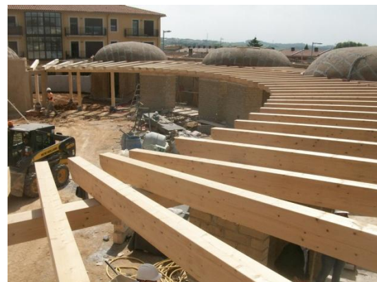
Imatge 21 La fusta laminada de pí i avet de la zona cobreix tot l'edifici 31
