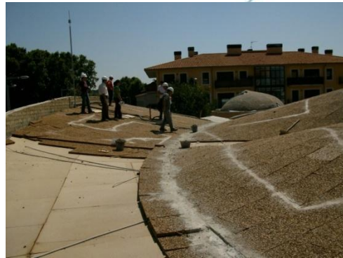
Imatge 25 Instal·lació de suro natural a l'escola 35
