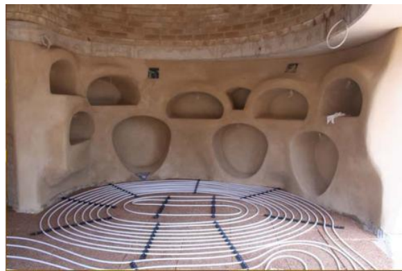
Imatge 39 Instal·lació de terra radiant a l'escola 49
