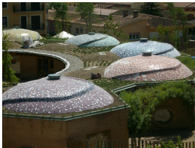
Imatge 36 Part exterior de les cúpules: s'observa la cúpula acabada i amb una corba sortint que pertany a la proporció àurea. 45
