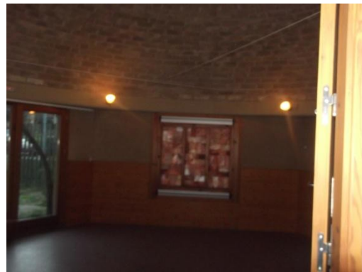
Imatge 26 Murs de sal situats a les finestres de la part sud de l'escola. 36
