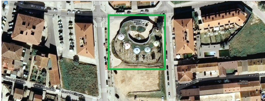
Imatge 7. Vista superior de l'escola bressol 11
