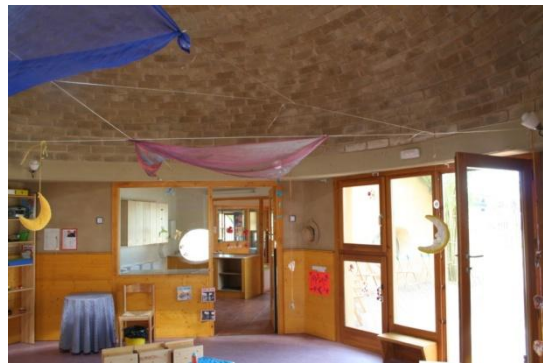
Imatge 15 L'obertura de les finestres és una condició indispensable per la ventilació natural 17
