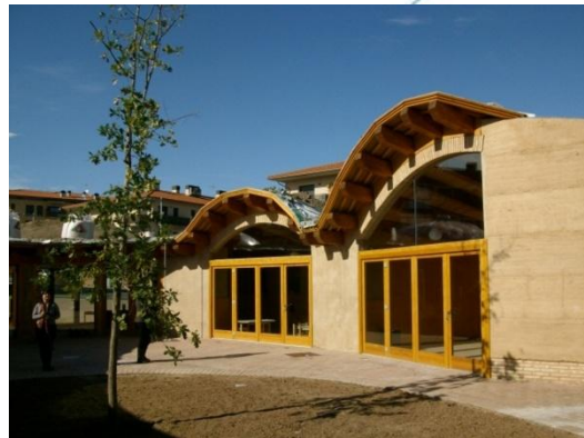
Imatge 22 Fusteries exteriors de l'escola acompanyades de grans vidres per la captació solar 32
