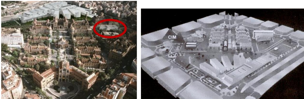
Imatge 27 Instal·lacions del CIM – Sant Pau (Imatge proporcionada pel Sr. Jordi Virgili Arumí durant la visita realitzada a l'Hospital de la Santa Creu i Sant Pau)
