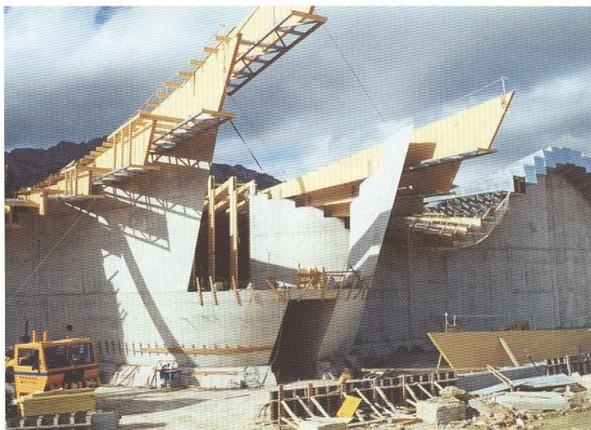
Vista acabado de muros del Núcleo Central
