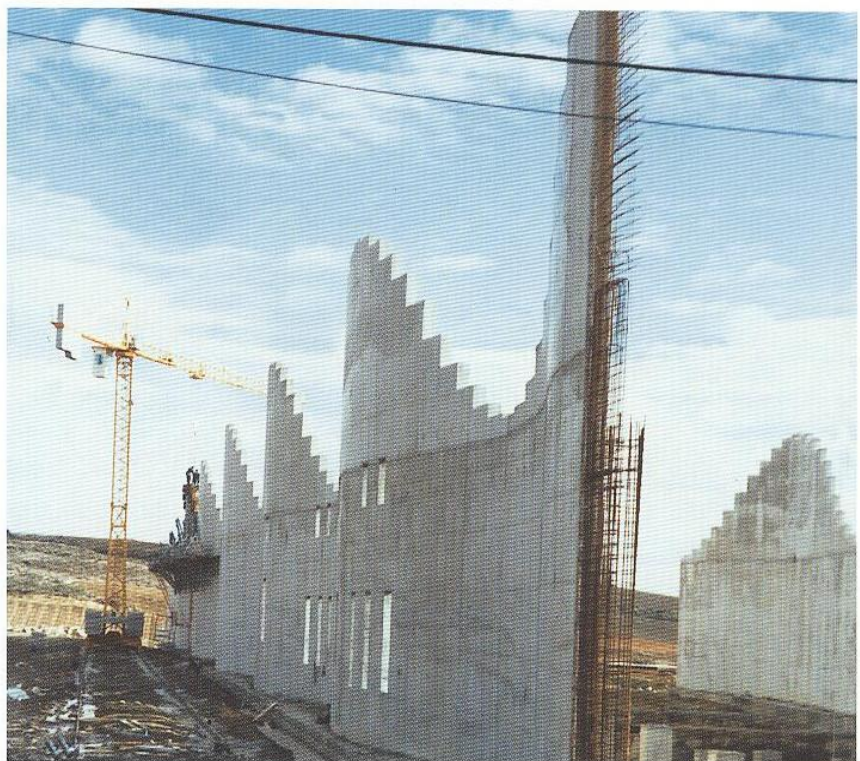
Vista acabado de muros perimetrales
