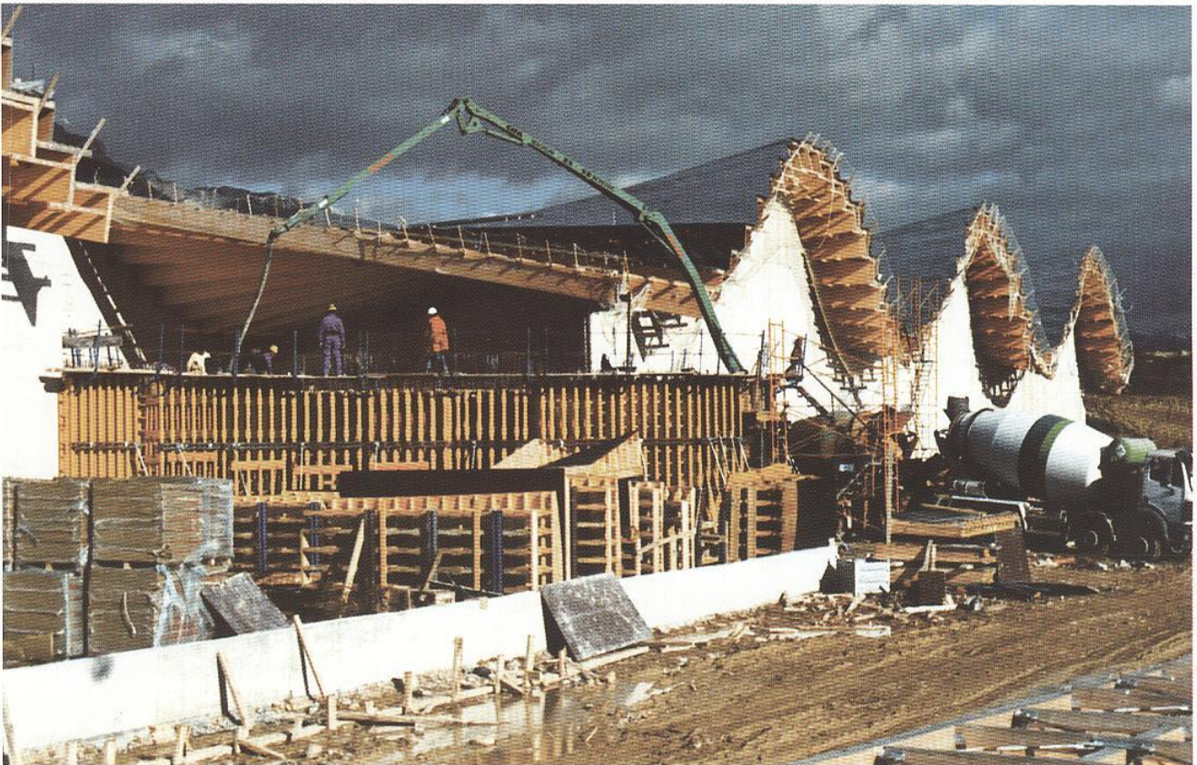
Vista hormigonado de 1ª tongada de Núcleo Central
