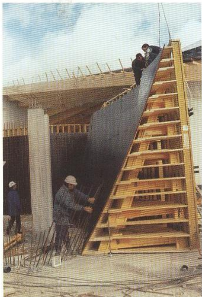
Colocación cajones especiales Top-50 para el Núcleo Central
