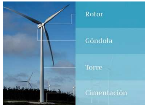
Fig. 6. Parts de l'aerogenerador
