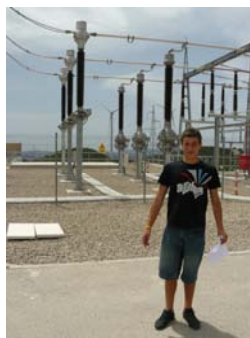
Fig. 99. Subestació del parc
