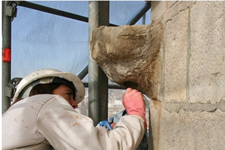
Imatge 30 . Una restauradora dóna forma a una gàrgola de Santa Maria del Mar
