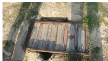
Sèquia Monar, en aquest tram feta amb parets de formigó armat, i reguera secundària al costat, en una rasa excavada en el terreny.
