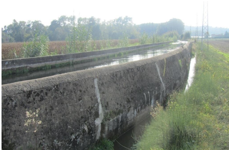
Sèquia Monar, en aquest tram feta amb parets de formigó armat, i reguera secundària al costat, en una rasa excavada en el terreny.
