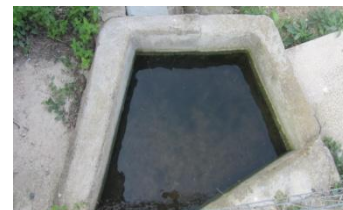
Sèquia Monar, en aquest tram feta amb parets de formigó armat, i reguera secundària al costat, en una rasa excavada en el terreny.
