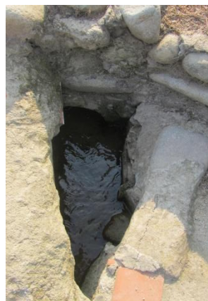
Diferents tipus d'ulls que serveixen per desviar l'aigua de les regueres terciàries o quaternàries cap a les hortes.
