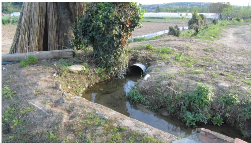
Reguera terciària que té un tram soterrat per permetre el pas dels hortolans d'una horta a una altra.
