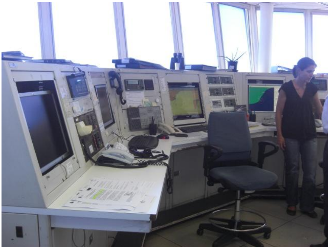
Interior de la Torre de Control
