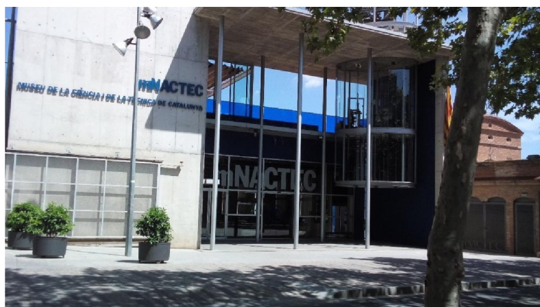
Figura 1. Entrada al museu de la Ciència i la Tècnica de Catalunya.
