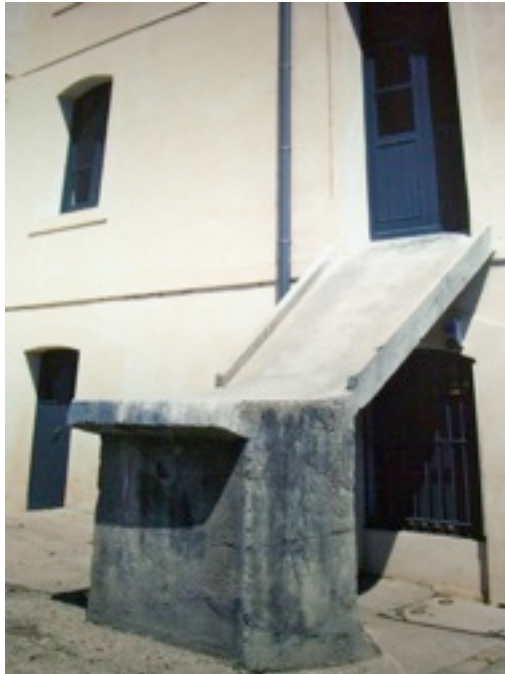
Figura 6.15. Rampa per la qual es llancen els sacs de farina per carregar-los al camió.
