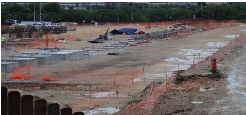
Construcció del parc temàtic Ferrari Land en el resort de PortAventura (obertura 2016). Imatge extreta de " pa-community.com "
