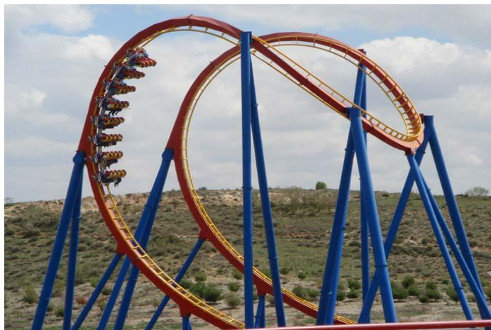
Exemple de "Cobra Roll" de la muntanya russa Superman del parc temàtic Warner Bros de Madrid. Imatge extreta de themeparkreview.com
