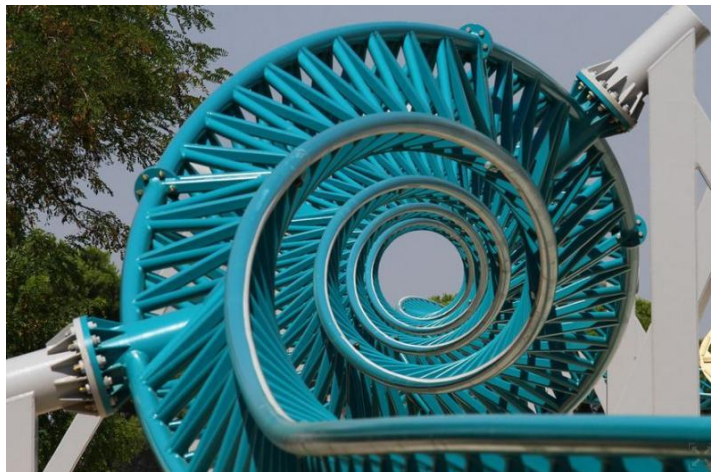
Exemple de quatre "Heartlines Rolls" que es troben en la muntanya russa Altair del parc temàtic "Cinecittà World" de Roma (Itàlia). Imatge extreta de forum.nolimits-exchange.com
