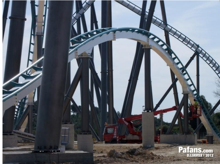
Exemple de "camelback" que podem trobar en la muntanya russa Shambhala de PortAventura. Imatge extreta de pafans.com
