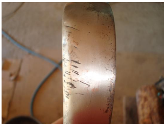
Foto 46: Esmerilat d'imperficcions del arc del far
