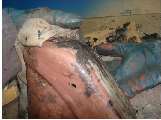
Foto 7: Netejant restes de decapant
