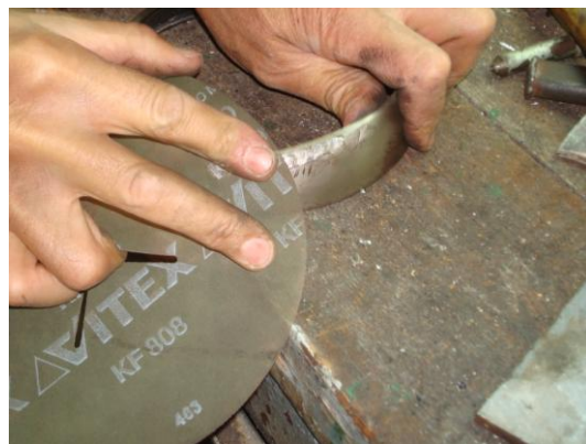
Foto 46: Esmerilat d'imperficcions del arc del far
