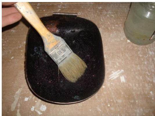
Foto 86: Aplicant decapant
