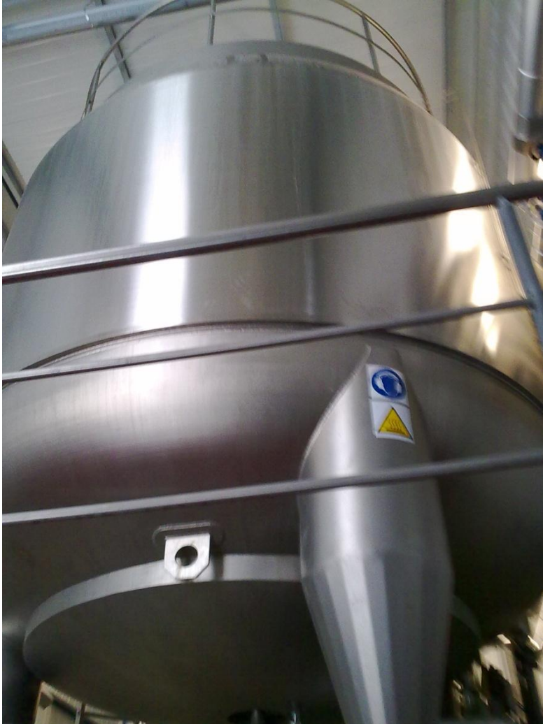
Tanc asèptic anomenat Tetra Alsafe de la planta de llet de l'empresa CAGSA de la marca Tetra Pak.
