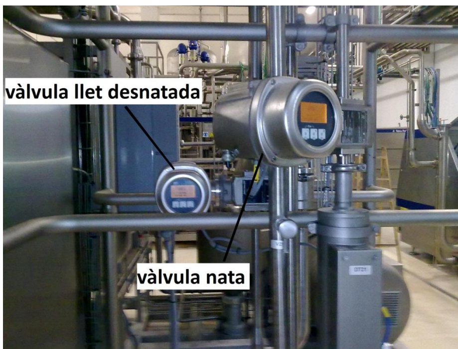
Estandarditzador amb les dues vàlvules anomenat Tetra Alfast de la marca TetraPak.
