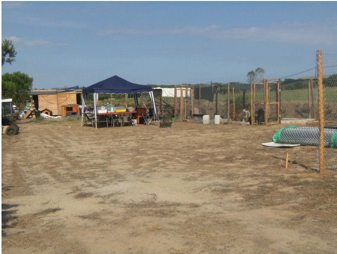
Vista general de la protectora en construcció.
