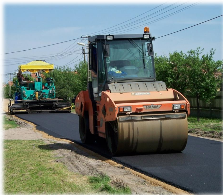
Construcció de carreteres i camins fins a la zona d'explotació
