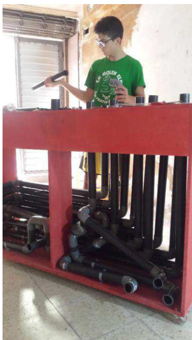
Imatge 26: Procés de construcció.
