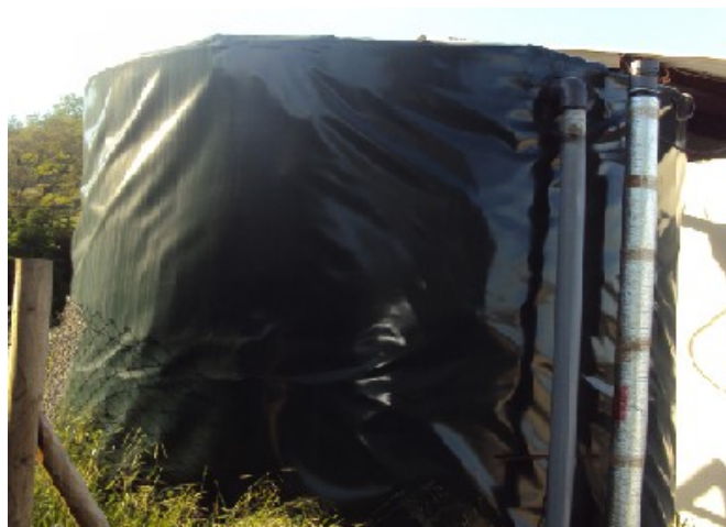
Figura 22. Dipòsit de preescalfament, escalfa el purí abans de ser introduït al digestor.
