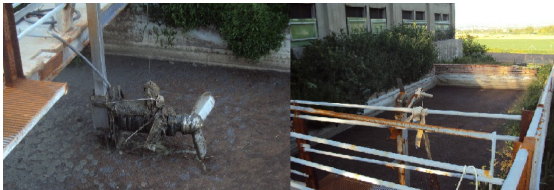
Figura 16. Dipòsit de premescla amb el corresponent agitador mecànic.
