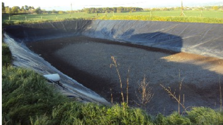
Figura 23. Bassa on van a parar els purins ja digerits i el purí dolent.
