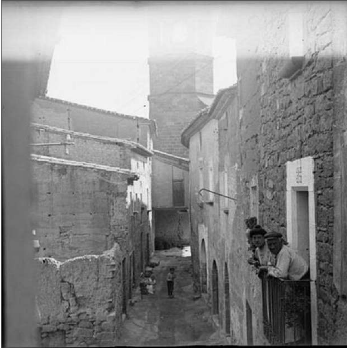
136. 1909. El carrer de la vileta amb vista a la torre del campanar. Fotografia de Josep Massot i Palmés, sobre placa de vidre. Una altra de les imatges més antigues d'Artesa de Lleida (Arxiu ICC).
