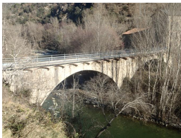
Imatge 49: Pont d'Arsèguel. L'estructura de l'antic pont era tant resistent que va ser utilitzada per fer-hi passar la carretera per damunt.
