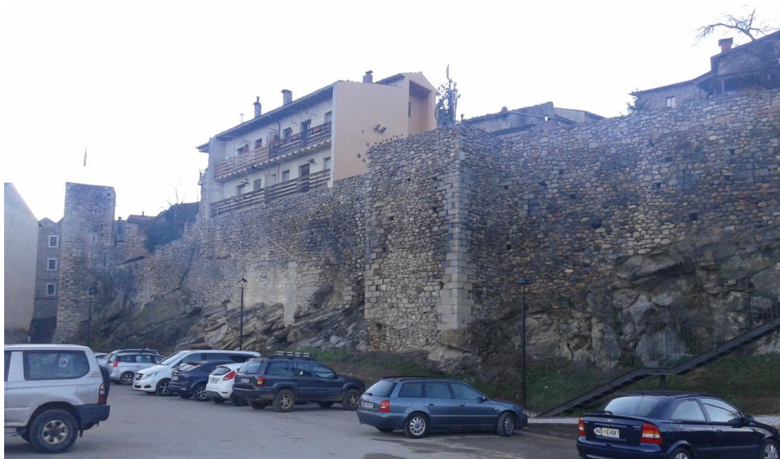
Imatge 70: Restes de les muralles medievals de Bellver de Cerdanya. Es conserven de forma íntegra les de damunt el penya-segat del Segre i les del flanc est del poble, que són les de la fotografia. Font: Miquel Sirvent Viñas Data: 20-12-2014
