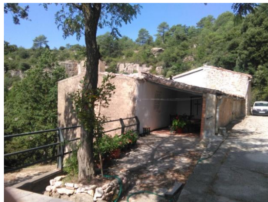
Entrada a l'habitatge de l'ermitana Font: pròpia
