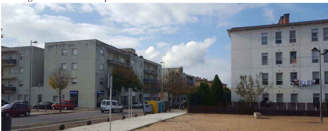
Imatge de l'Av. Josep Irla. A l'esquerra podem veure un dels habitatges de protecció oficial privada. A la dreta els de protecció oficial pública.
