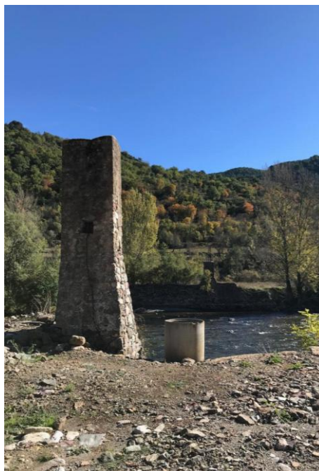
Font pròpia. Torres que facilitaven la conducció de l'aigua salada a l'altre costat del riu.
