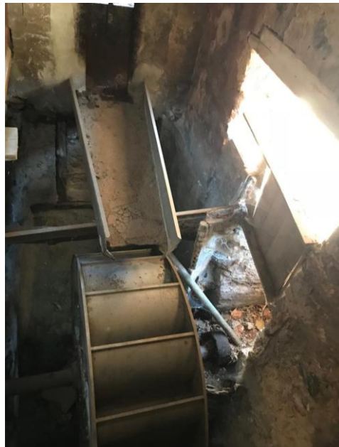
Font pròpia. Entrada d'aigua dolça per moure la sínia i accionar la bomba.
