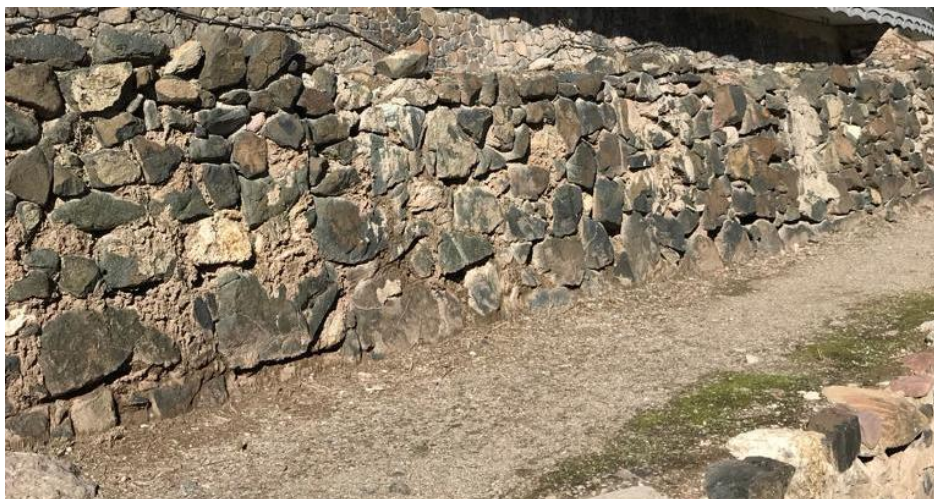
Font pròpia. Mur de contenció
