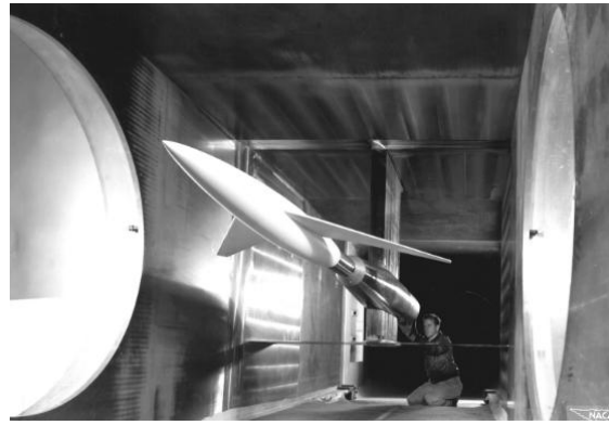
Il·lustració 19: Experimentació d'un prototip en un TDV supersònic ( M > 1 ) (Font: Viquipèdia)
