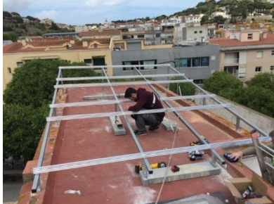
Imatge 13: Operari muntant suports
