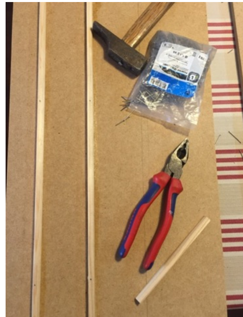
Imatge 12. Quan ja es té el lloc exacte on es volen situar les planxes, s'enganxen, amb cola d'impacte i claus, dos llistons per cada planxa llarga de conglomerat, a 5 i 20 cm de la part superior.
