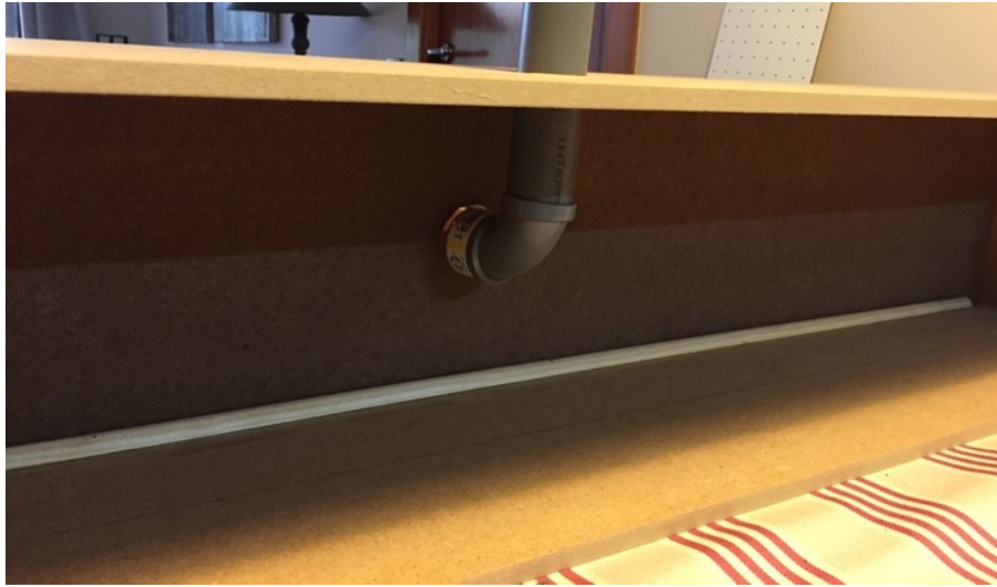
Imatge 14. Després d'haver fet també el forat de la planxa inferior de melamina, i d'haver ajuntat les quatre planxes de conglomerat, es fa la unió dels dos forats per on ha d'entrar l'aire.
