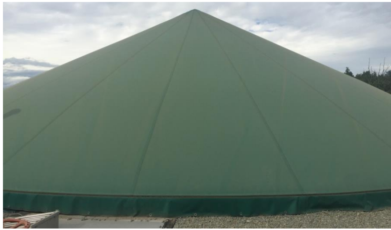
Figura 8. Cúpula del Digestor
