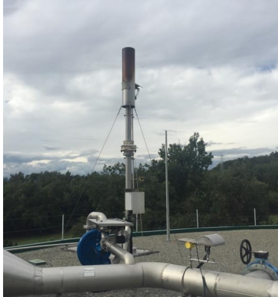
Figura 15. Xemeneia per cremar el biogàs
