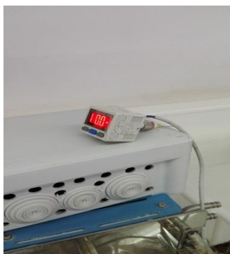
Figura. 1. Mesurador de pressió
