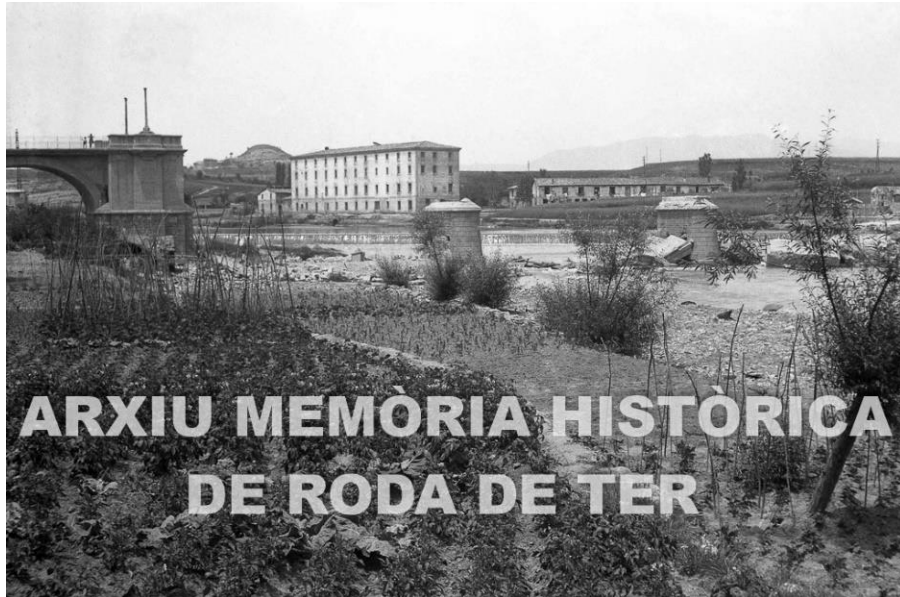
Destrucció dels ponts de Roda. 3 de febrer de 1939. Font: Arxiu memòria històrica de Roda de Ter.
