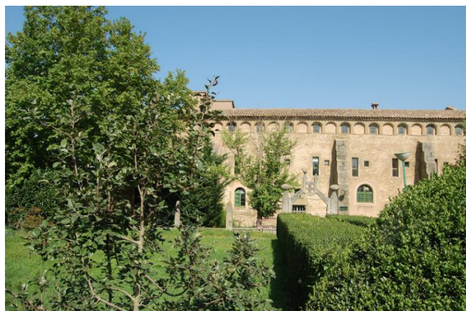
Edifici i jardins del convent de Sant Tomàs de Riudeperes de Calldetenes.
