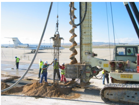
Sistema de perforació amb motor elèctric
