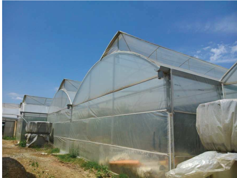
Imatge 30: hivernacle multicapella amb obertures zenitals
