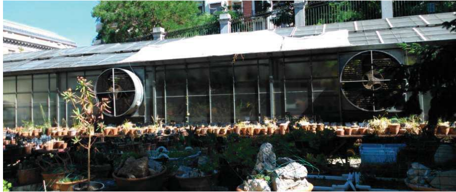
Imatge 41: hivernacle del Real Jardín Botánico de Madrid amb ventilació forçada
