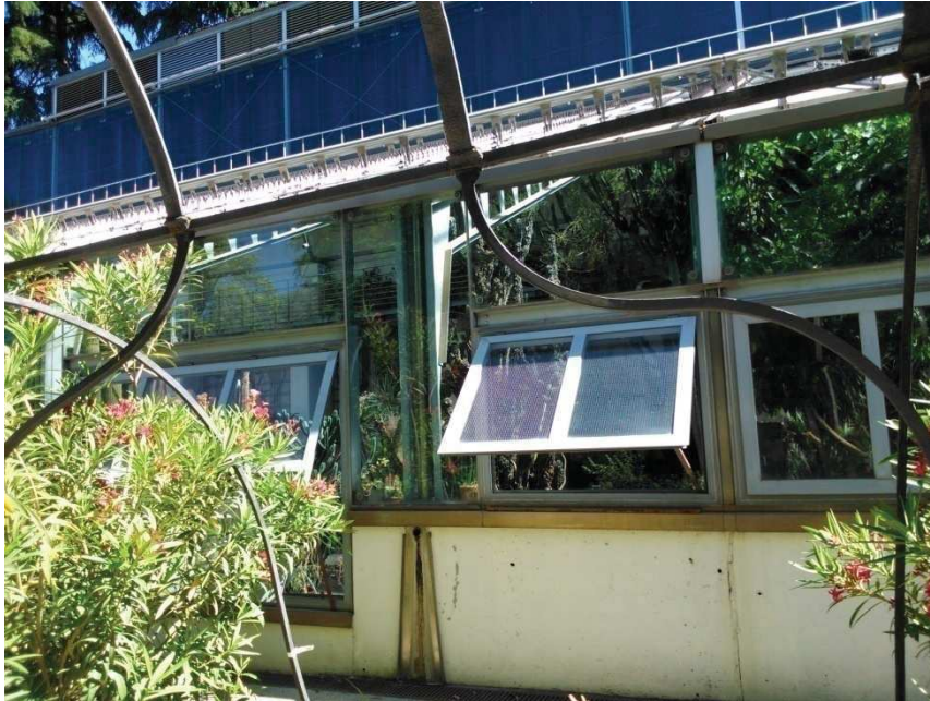
Imatge 32: exterior de l'hivernacle del Real Jardín Botánico de Madrid, on es pot veure la ventilació lateral i el sostre cobert de plaques solars fotovoltaïques
