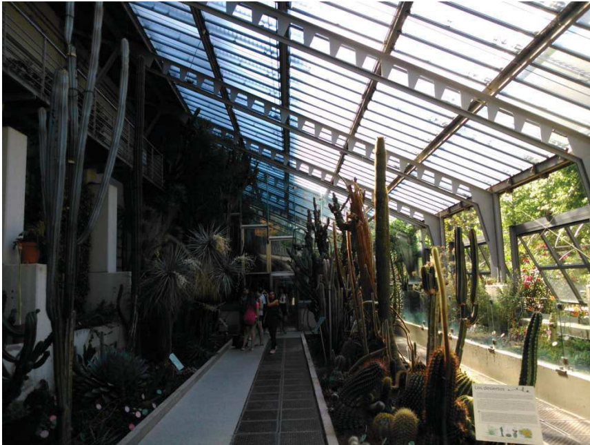
Imatge 31: interior d'un hivernacle del Real Jardín Botánico de Madrid, on es pot veure la sòlida estructura, els panells de vidre i la ventilació lateral
