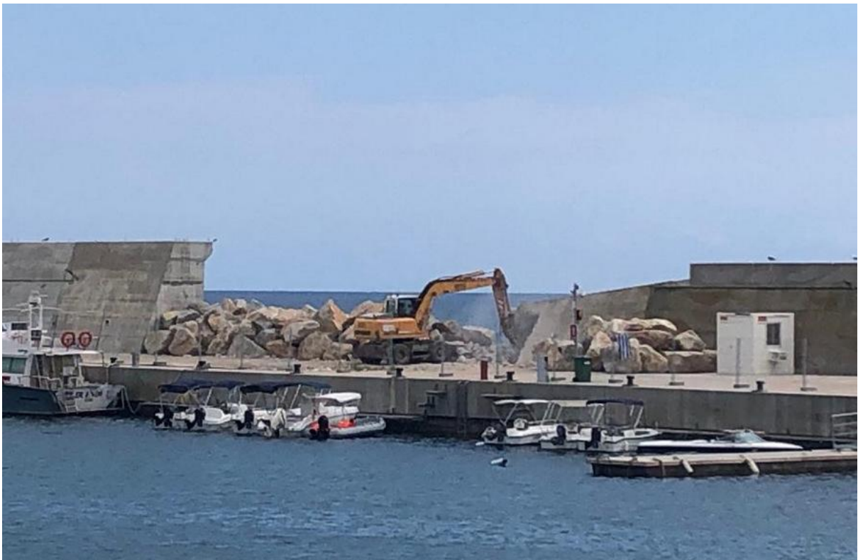
Figura 14: Reparació del dic de Blanes danyat després de la tempeste Glòria (Comienzan las obras de reparación en el dique de Blanes, 2020)
