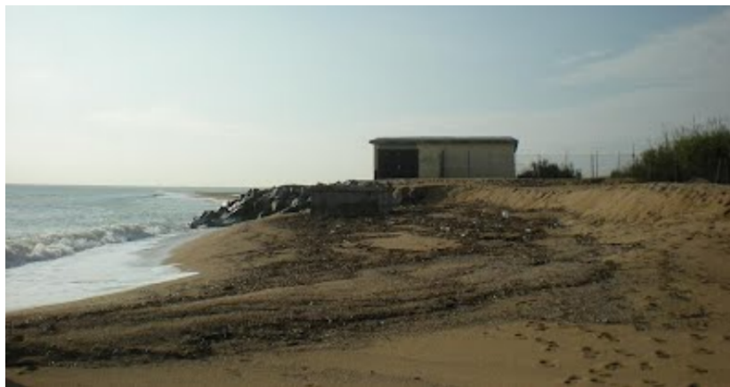
Figura 11: Espigó de l'estació de bombeig de la desaladora de la Tordera (Dinámica litoral, 2021)
