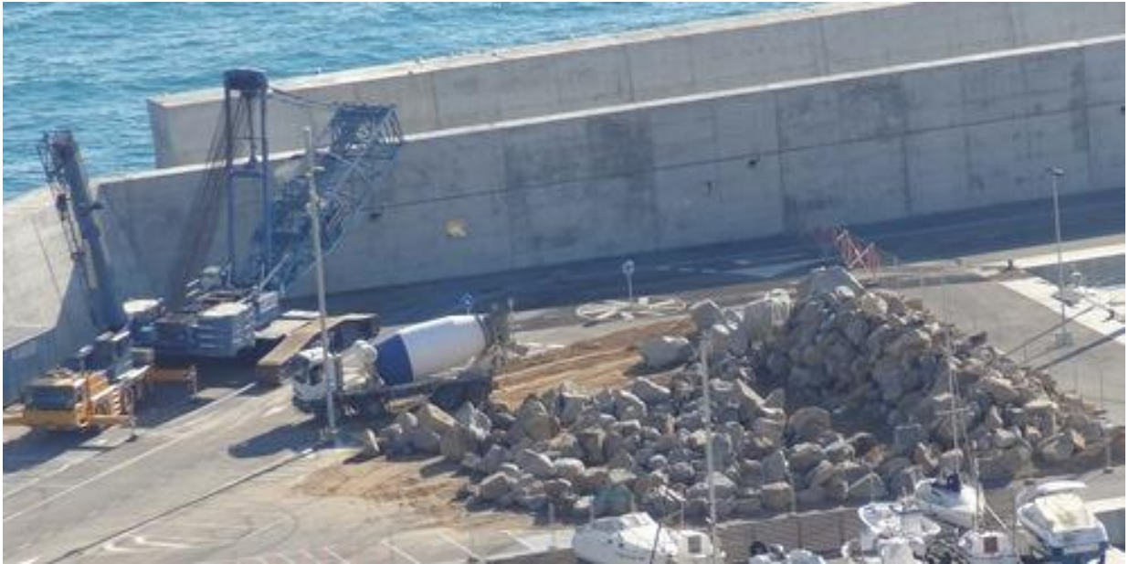
Figura 13: Ampliació del dic de Blanes amb roques i formigó per assegurar l'assentament i fixació (La Generalitat refuerza con bloques de hormigón una parte del dique del puerto de Blanes, 2013)
