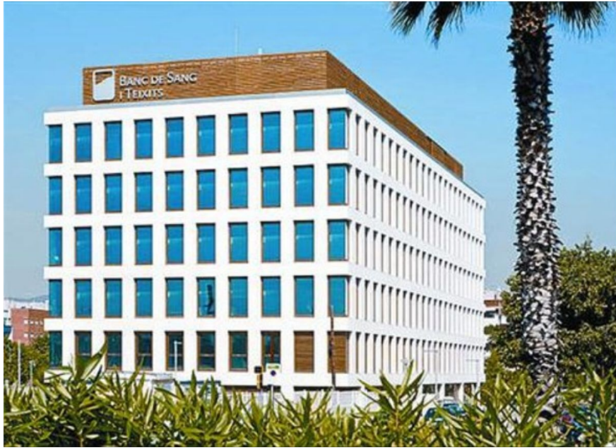
Imatge 1: Edifici Banc de Sang i Teixits de Catalunya, Barcelona, Poblenou
