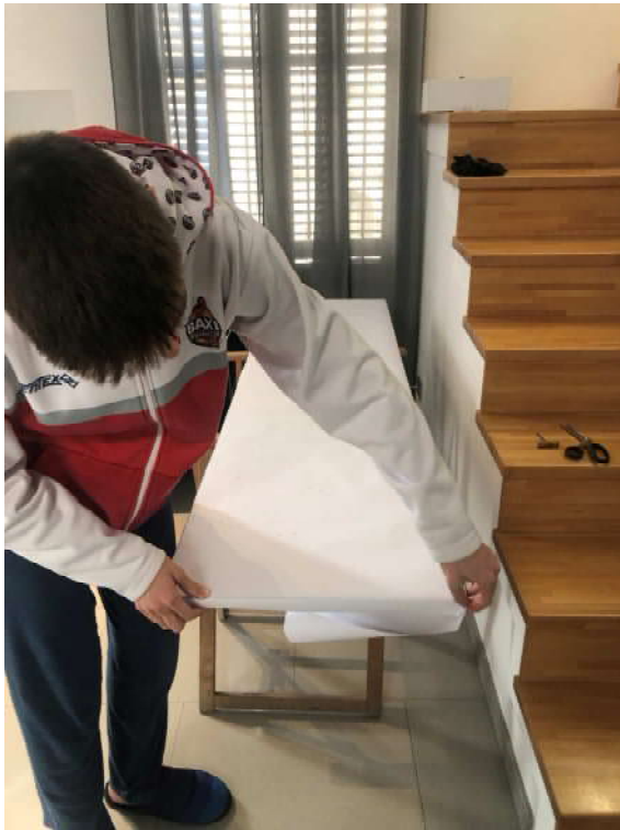
Fotografia 107: Col·locació de plantilla amb els forats del suports
