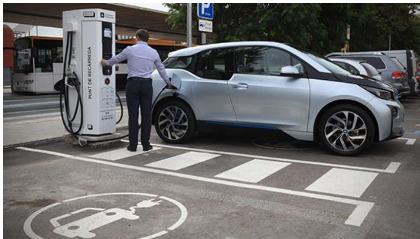
FIG. 40 - punt de càrrega dels cotxes elèctrics
