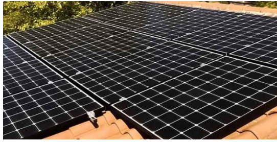
FIG. 20 - instal·lació de plaques monocristal·lines
