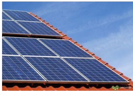
FIG. 21 - instal·lació de plaques policristal·lines
