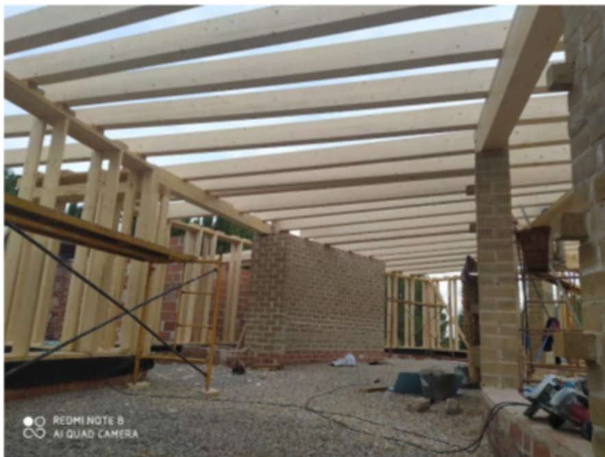
Font 48: Col·locació de les bigues horitzontals de fusta laminada de pi
