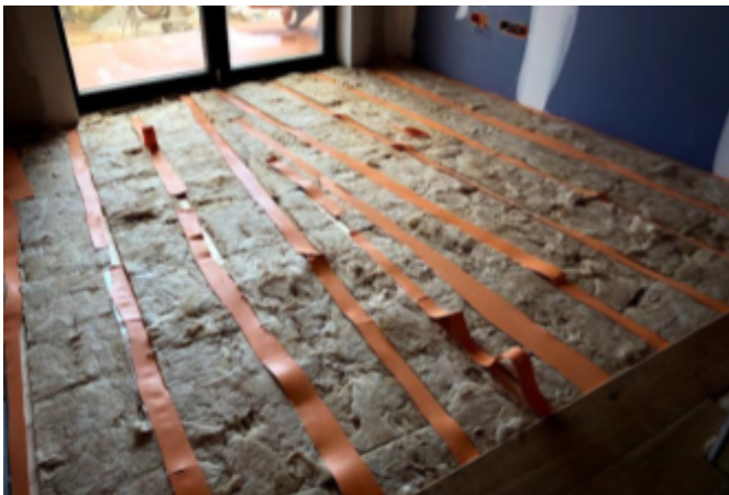
Font 60: Col·locació de l'aïllant de fibra de roca i el parquet
