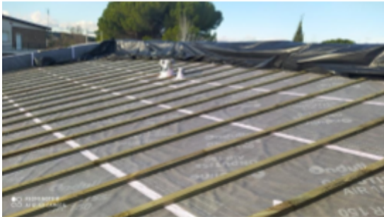
Font 54: Subjectió de la làmina impermeable i col·locació de les teules
