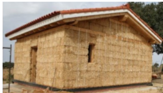
Font 4: Edifici construït amb palla utilitzant la tècnica Nebraska
