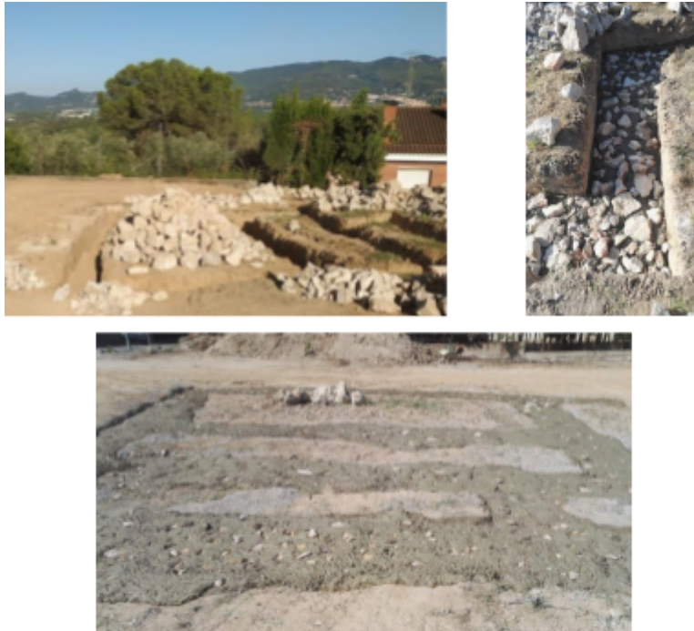
Font 42: Fonaments de roques i ciment
