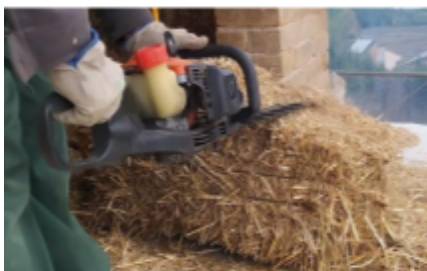
Font 55: Anivellament de les bales de palla i col·locació als murs
