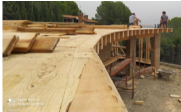
Font 49: Sostre fet amb fusta laminada de pi
