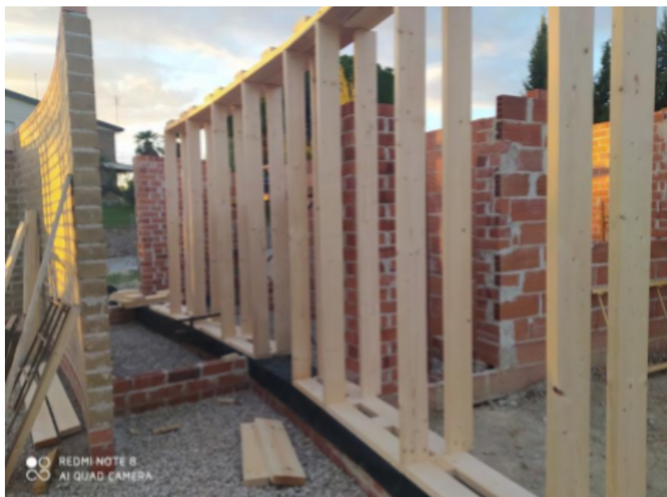
Font 47: Estructura de l'habitatge amb fusta laminada de pi
