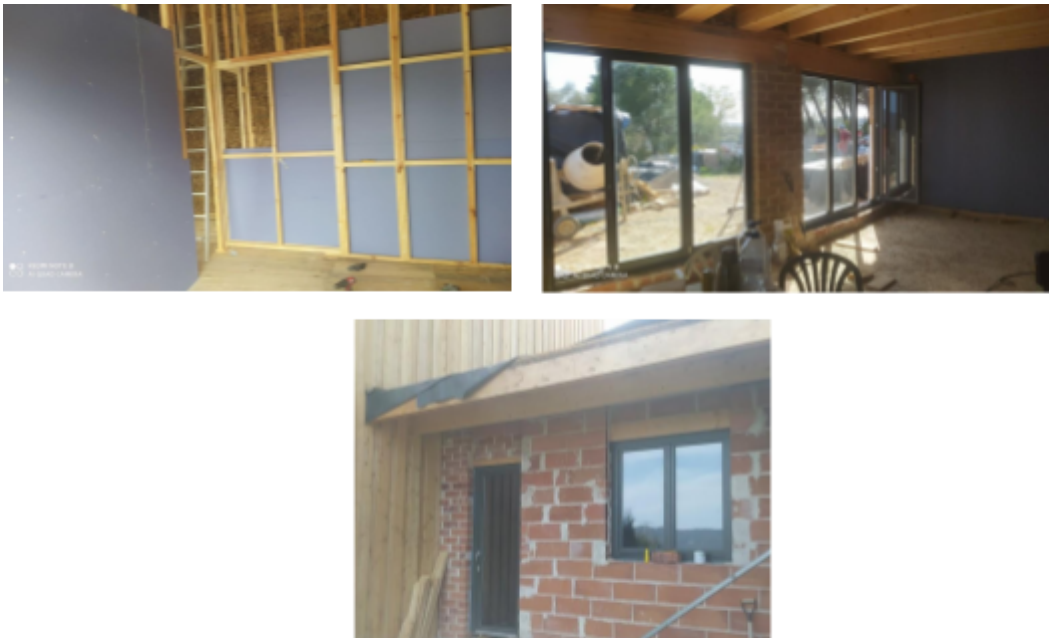
Font 58: Instal·lació del pladur, portes i finestres
