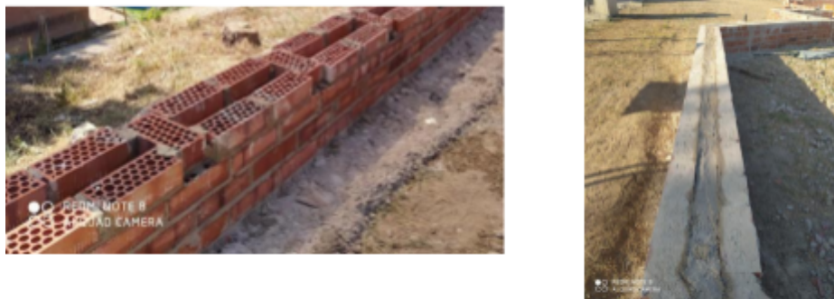
Font 43: Sòcol de totxos i ciment de calç
