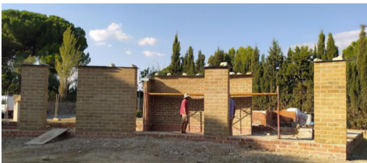
Font 45: Construcció de les columnes amb maons BTC
