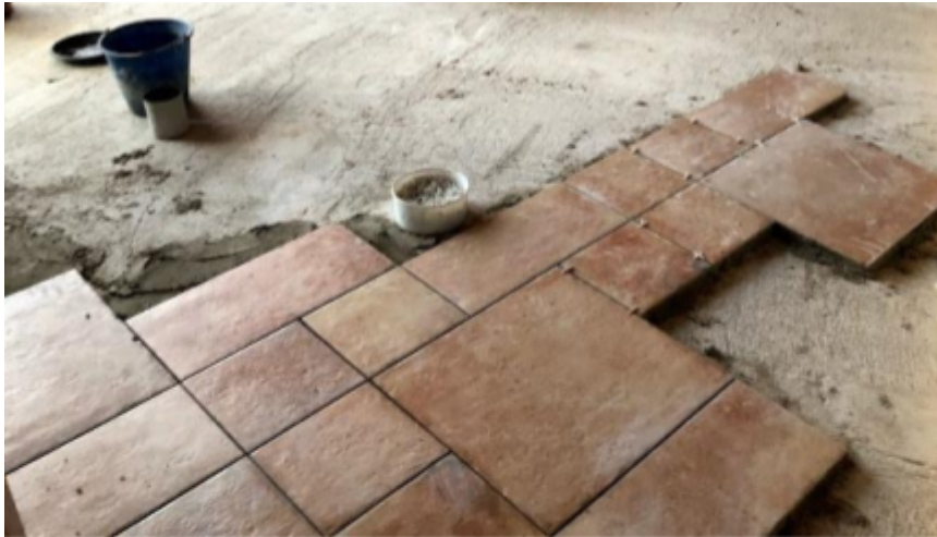
Font 59: Fixació de les rajoles sobre el ciment de calç
