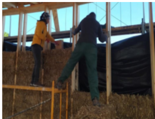
Font 55: Anivellament de les bales de palla i col·locació als murs
