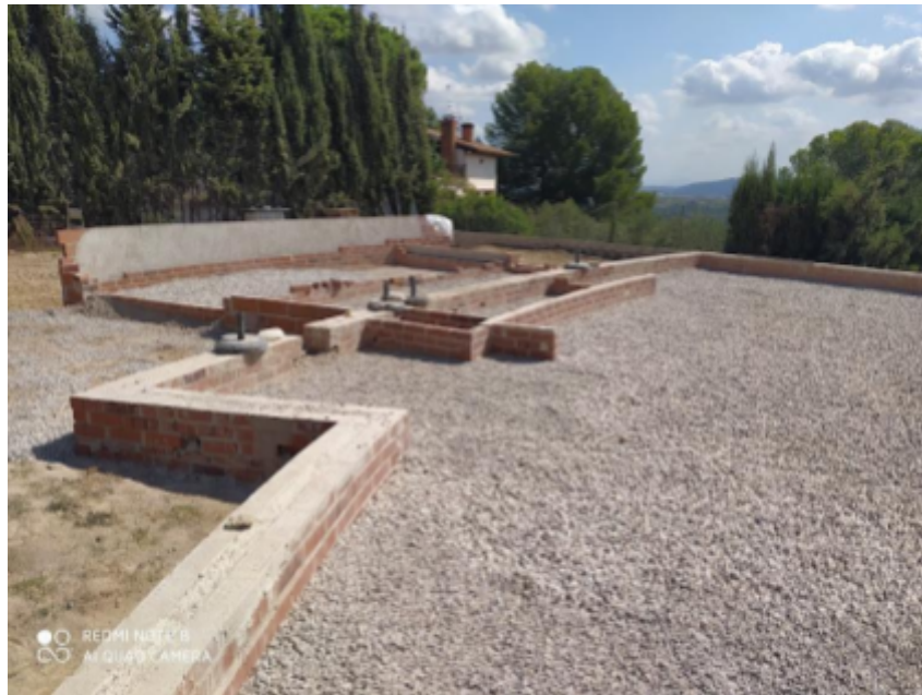
Font 44 : Anivellament del terra amb grava
