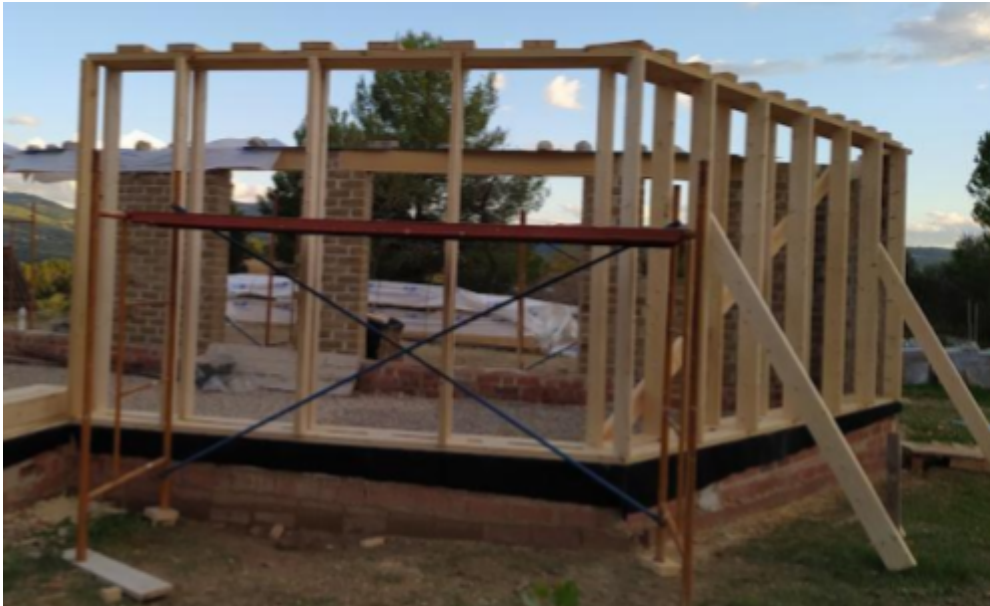
Font 46: Col·locació de la làmina impermeable i l'estructura de l'habitatge amb fusta laminada de pi
