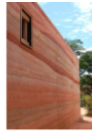
Font 24: Mur de terra utilitzant la tècnica tàpia
