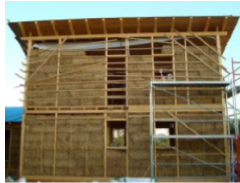
Font 5: Construcció d'un edifici de palla amb la tècnica CUT
