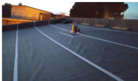
Font 53: Tancament amb fusta artificial i recobriments amb la làmina impermeable
