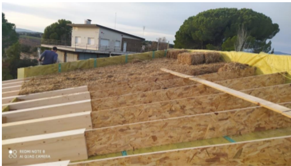
Font 52: Aïllament tèrmic i acústic amb bales de palla i fusta
