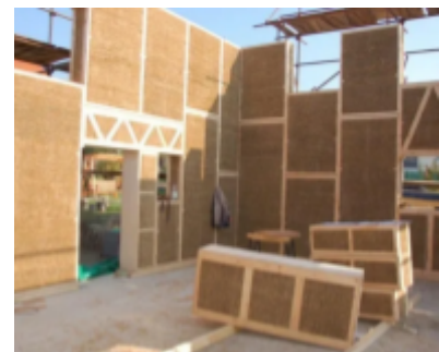
Font 7: Edifici construït amb panells prefabricats de palla
