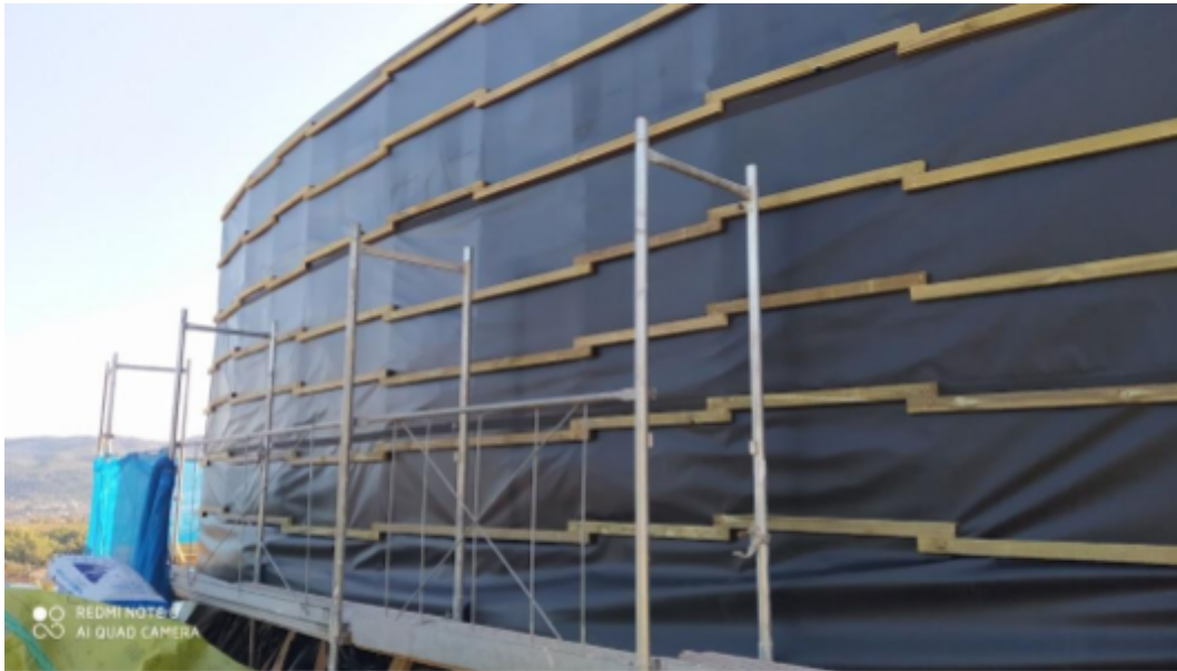
Font 56: Subjecció de la làmina impermeable amb llistons de fusta
