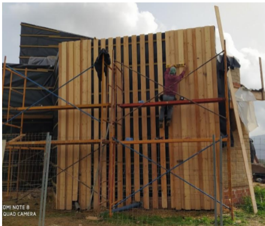
Font 57: Disposició de les làmines de fusta de Làrix siberià
