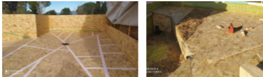
Font 61: Inclinació del sostre per a la recollida d'aigües pluvials
