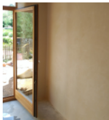
Font 9: Revestiment de calç i argila
