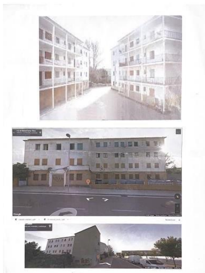
Figura 2.29. Fulls amb anotacions a sobre les imatges de l'estat actual de l'edifici a remodelar.
